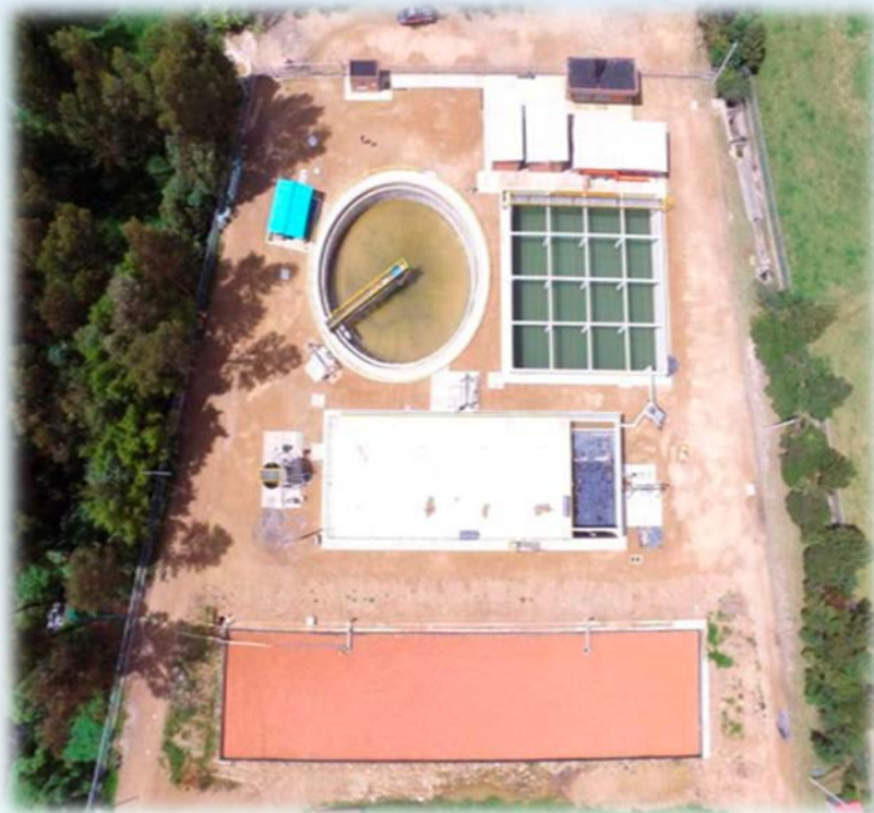
■ Construcción Planta de Tratamiento
